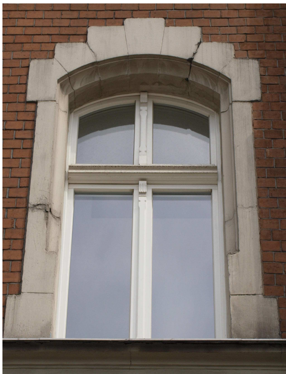
Rys.3. i 4. Typowe uszkodzenia detalu kamiennego, elewacja zachodnia.
