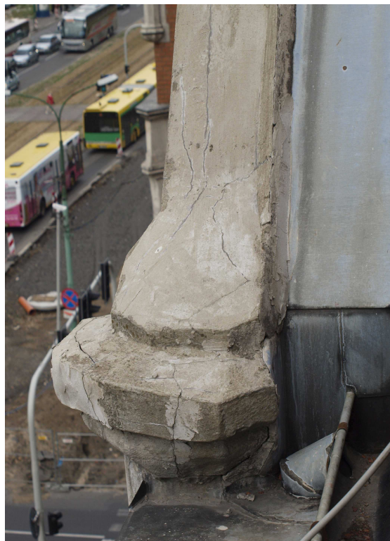
Rys.3. i 4. Typowe uszkodzenia detalu kamiennego, elewacja zachodnia.
